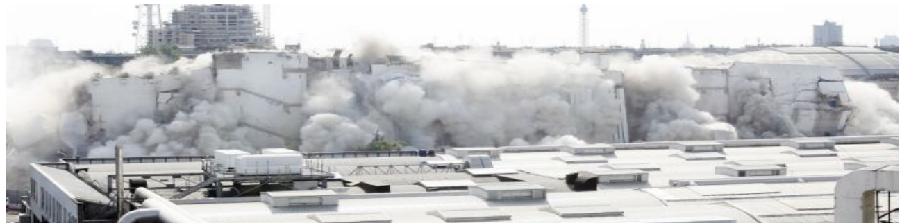
Demolizione per implosione attraverso l'uso di esplosivo
