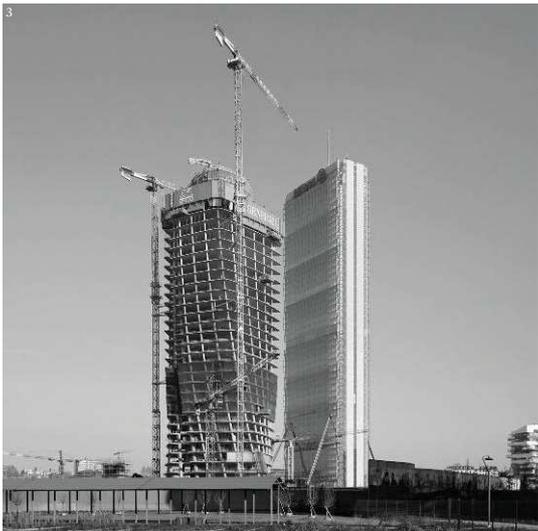
collaborazione parziale delle colonne collegate da un numero elevato di solai in soletta piena di calcestruzzo armato. Il funzionamento globale della struttura è a mensola, ovvero con trasferimento dei carichi orizzontali e dei momenti direttamente in fondazione.
